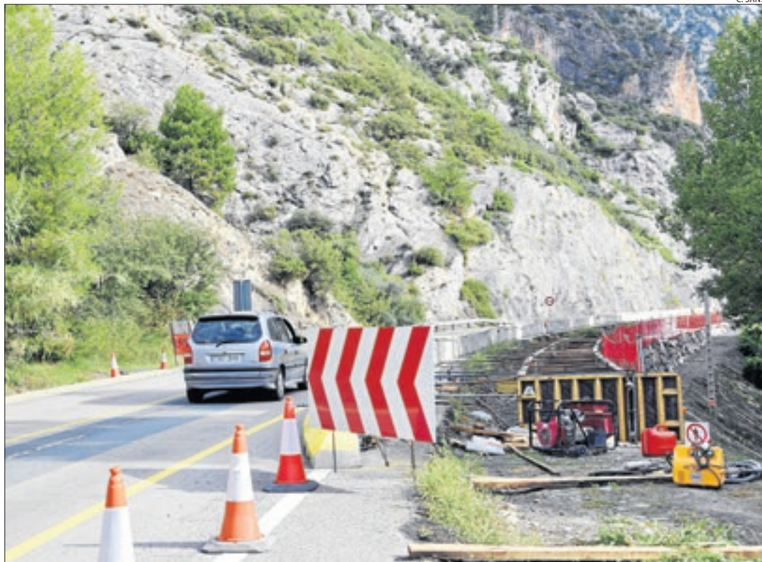
La calçada s'ampliarà fins als 10 metres amb un mur a la zona propera al Segre.
