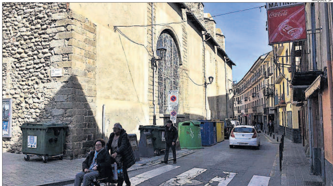
El mur exterior de l'església de Sant Domènec, que serà objecte d'un projecte de rehabilitació
