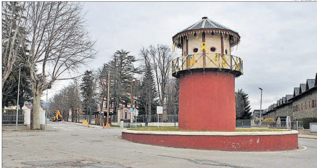
Les obres de remodelació dels carrers del voltant de l'estany i d'accés a l'Hospital de Cerdanya
