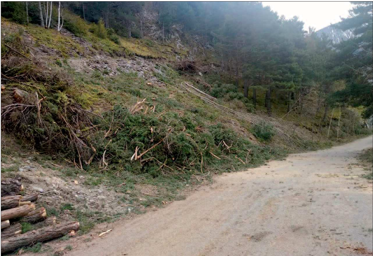
►► Arbres talats a la zona on s'ha de construir el ETR.
