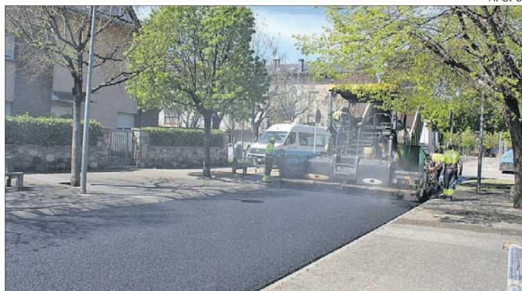
El projecte preveu l'asfaltatge de diverses vies.
