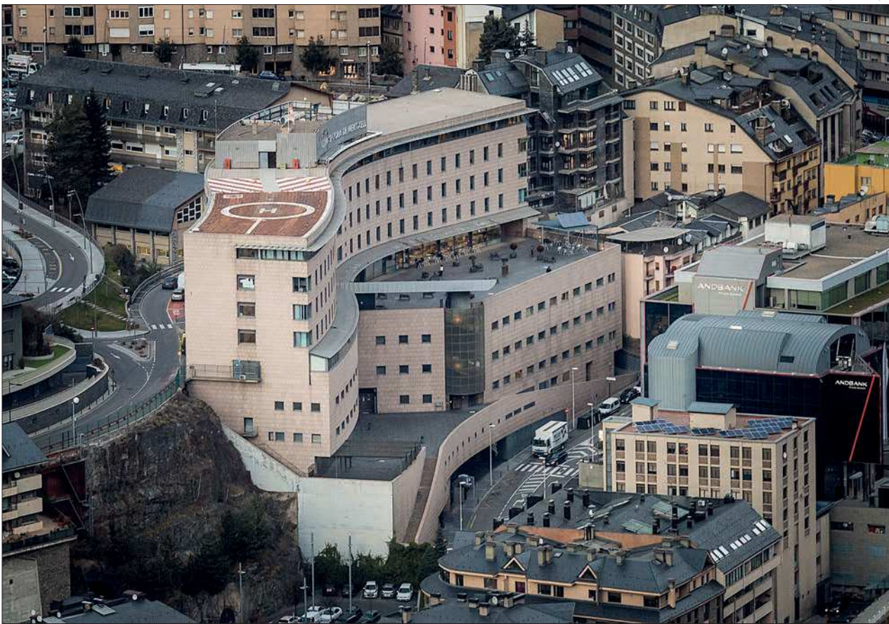
► Vista àeria de l'Hospital Nostra Senyora de Meritxell.
