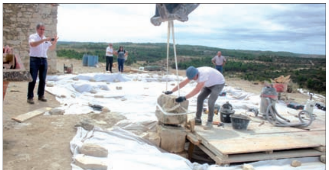
FOTO: Selena Garcia / L'inici dels treballs ahir va crear expectació entre els veïns de Llardecans
