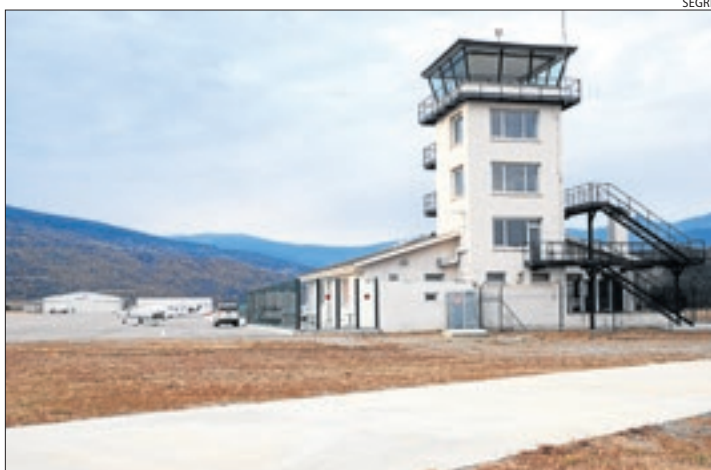
Les instal·lacions de l'aeroport de la Seu.
