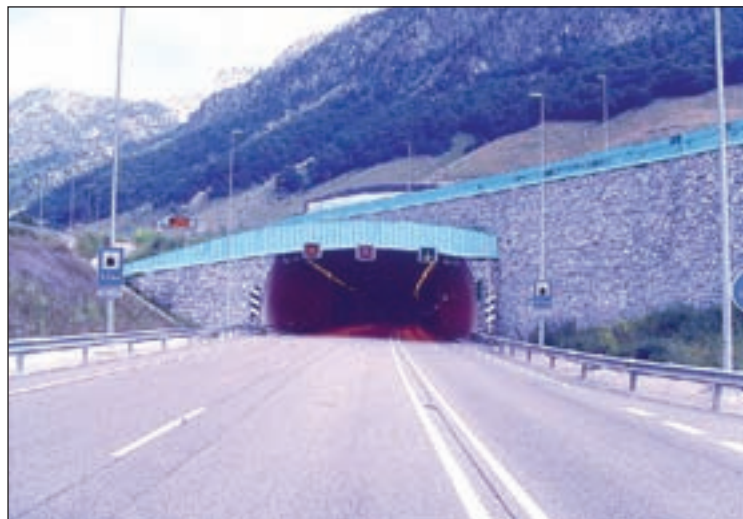
FOTO: Urisole/ Imatge de la boca sud del túnel de Vielha a l'N-230
