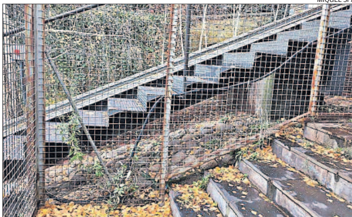
Detall de les vies per on puja la cabina de l'ascensor inclinat
