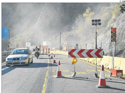
Obres al túnel de Tres Ponts a la C-14 a Organyà.
