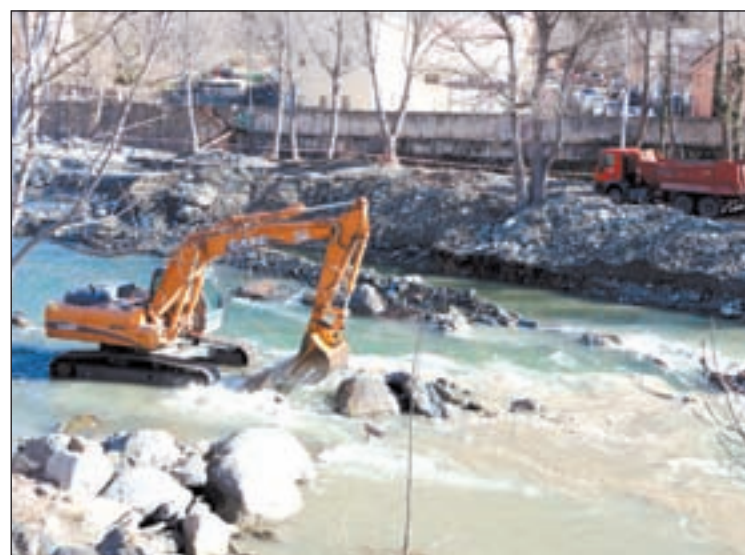
FOTO: Marta Lluovich (ACN) / Una excavadora treballant ahir al riu
