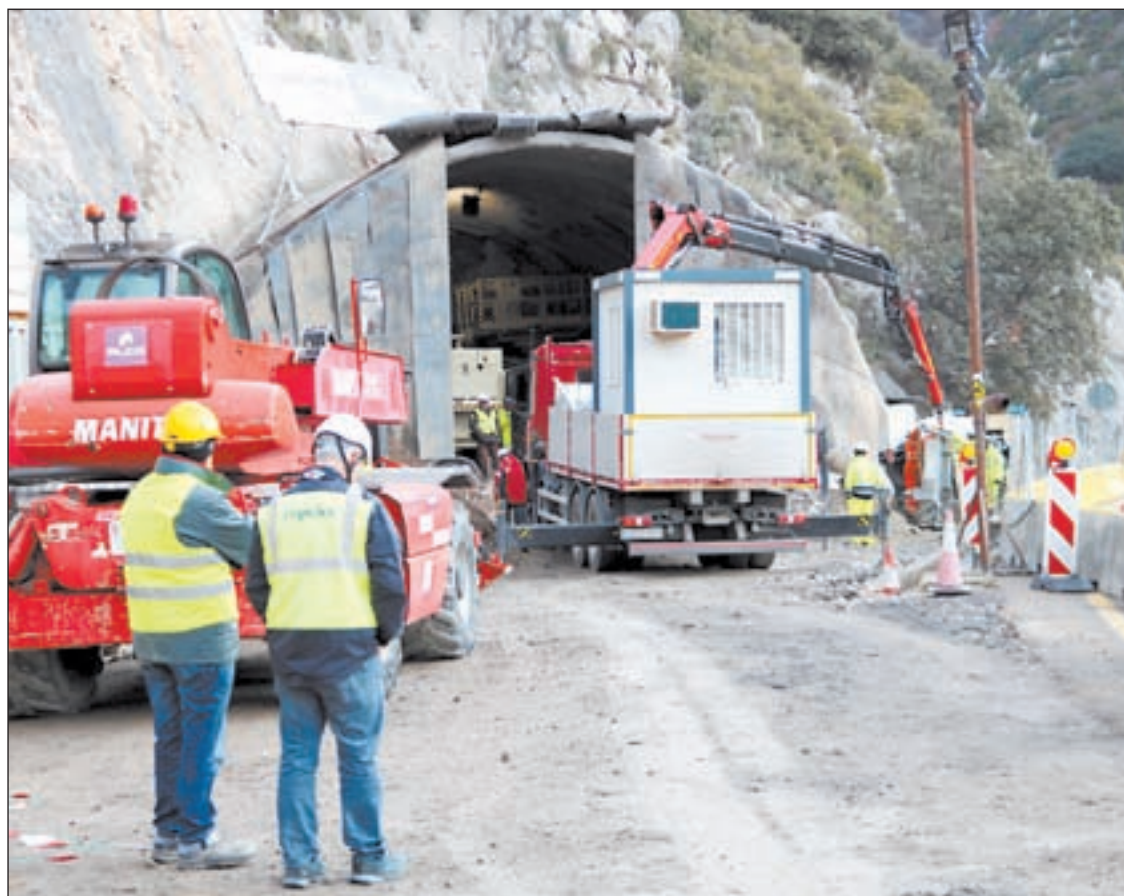
FOTO: ACN/ Operaris treballant al túnel de Tres Ponts, obres que continuaran durant els propers mesos
