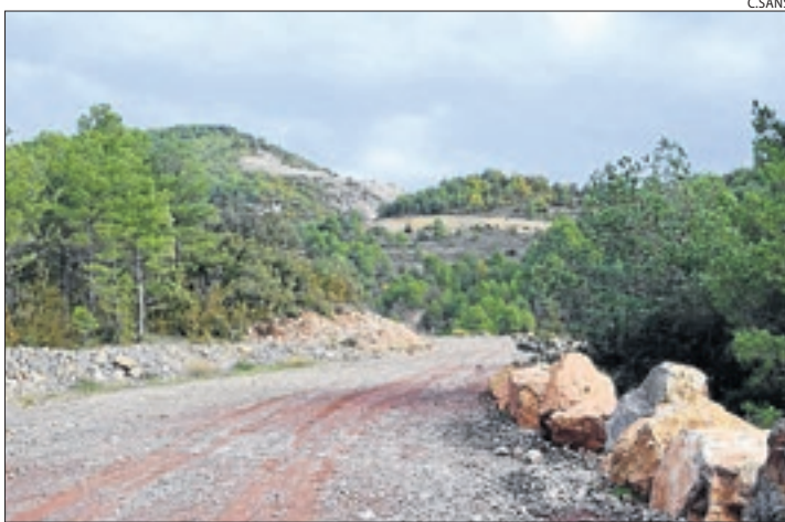
Knauf va construir l'accés des de l'N-260 fins a la planta.
