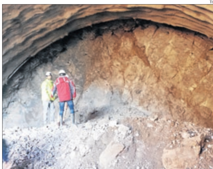
Les obres per excavar el túnel de Tres Ponts a la C-14.
