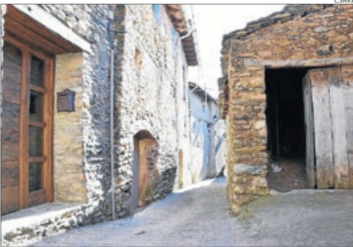
El carrer d'Estamariu on s'abordan les obres.
