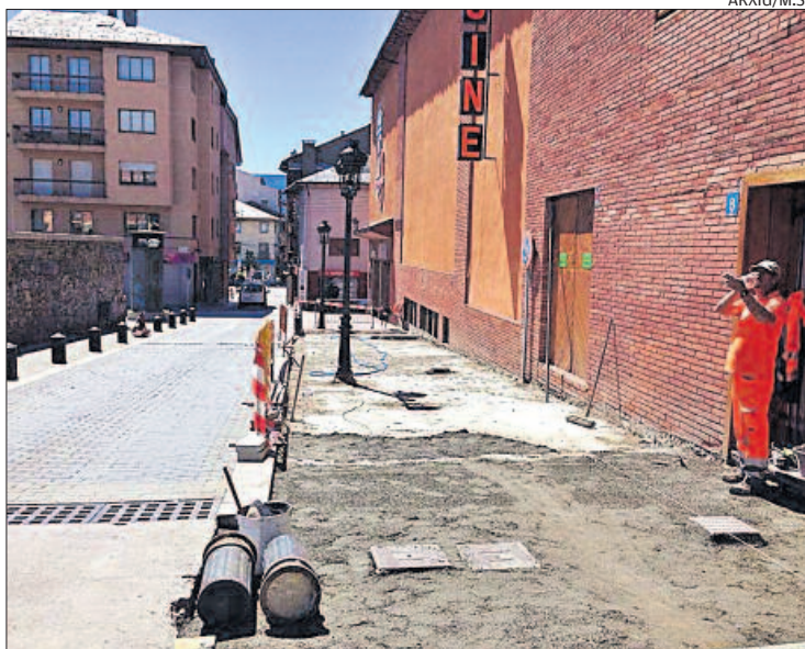
Obres a les voreres de la part superior del carrer Major de Puigcerdà
