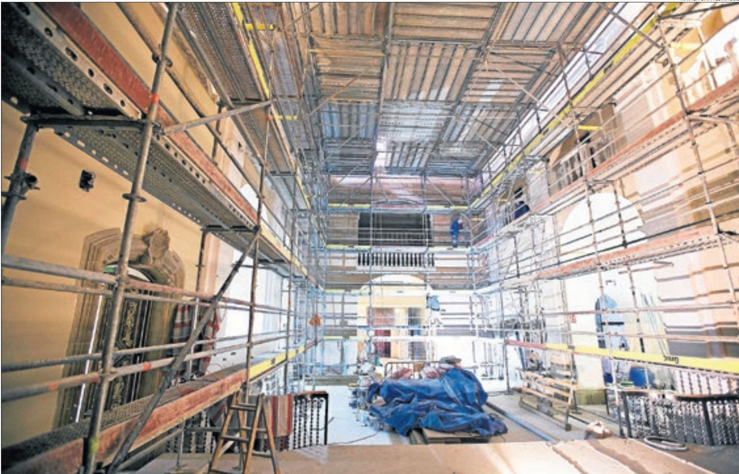
Vista de l'interior de l'Auditori de Cervera, totalment ple de bastides, a punt de finalitzar les obres de remodelació.
