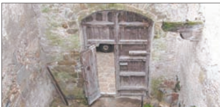
FOTO: Ajuntament Peramola / Imatge de l'interior de l'edifici
