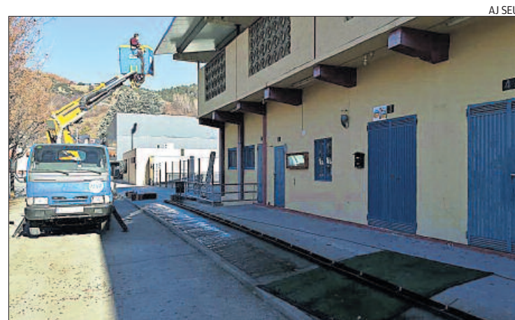
La instal·lació de la canal que recollirà l'aigua del teulat
