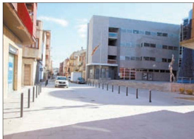
FOTO: Jordi Pascual / Zona en la qual s'ha efectuat la millora
