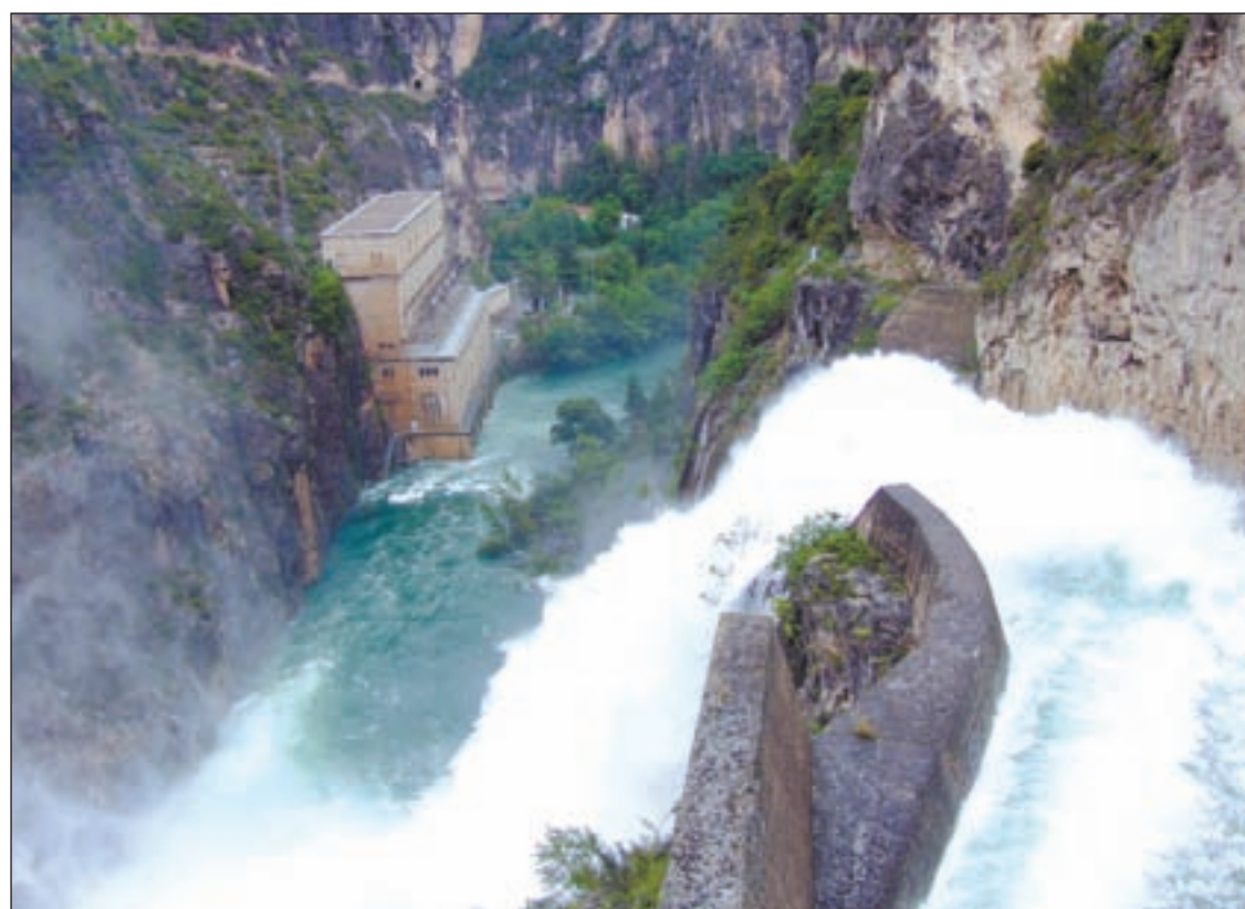
FOTO: Endesa / Foto d'arxiu de la central hidroelèctrica de Camarasa, a la comarca de la Noguera
