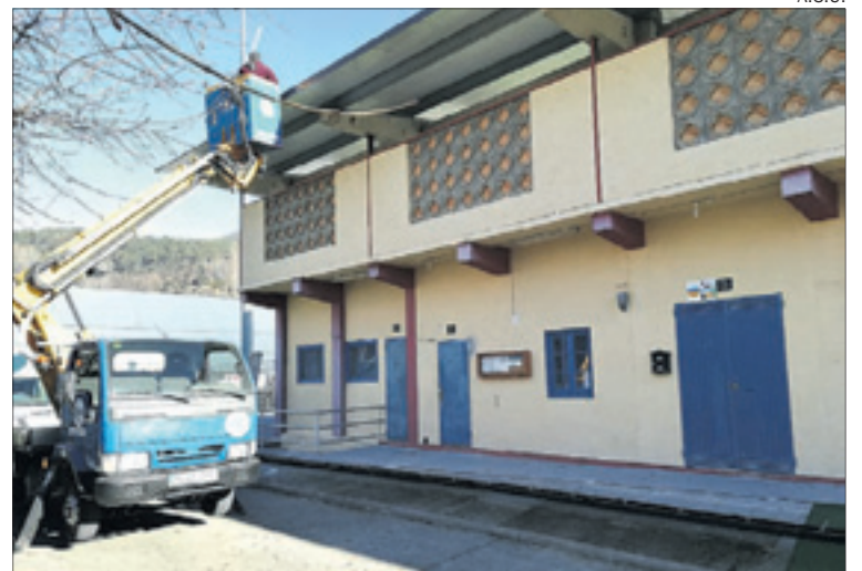
Les obres per instal·lar una canal a la coberta de les graderies es van fer ahir.
