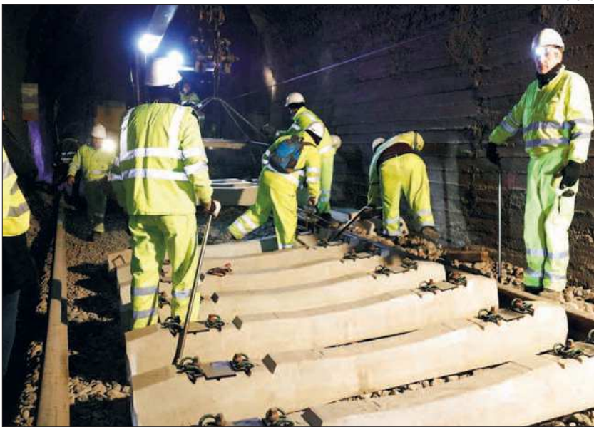
► Treballs de substitució de vies al tren de la Pobla.
