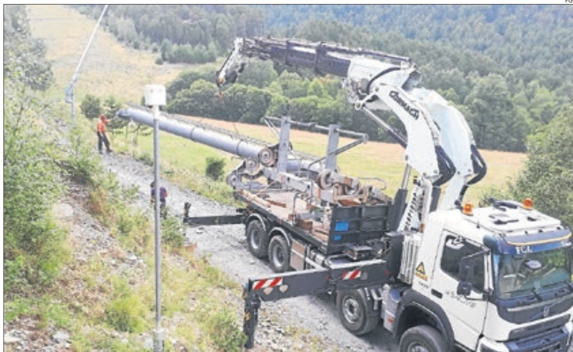
Imatge del desmuntatge del telecadira de la Roca de l'estació d'esquí d'Espot.
