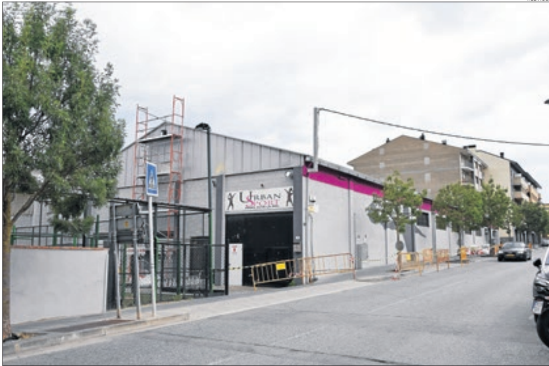
L'operari reparava la teulada d'un gimnàs a l'avinguda Guillem Graell de la Seu.
