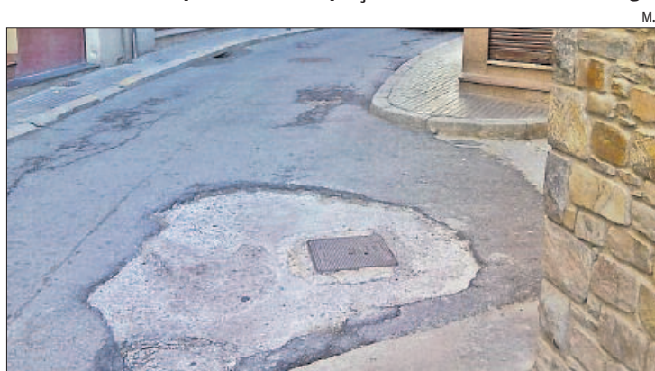
El ferm malmès del carrer dels Ferrers que ara es renovarà
