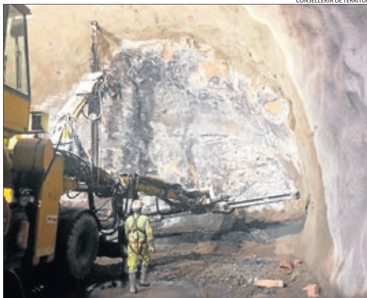
Imatge dels treballs de perforació a la boca sud del túnel.
