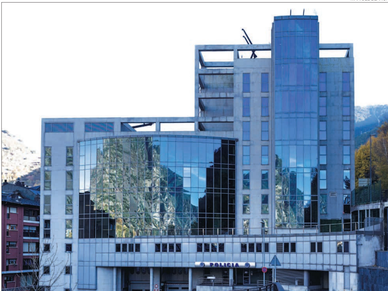
► L'edifici central de la Policia.
