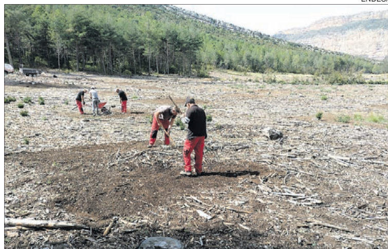
Operaris treballant a la Reserva de Boumort.
