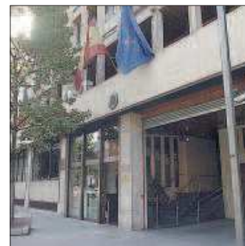
Façana del consolat espanyol.
