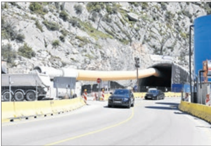
Les obres del túnel de Tres Ponts.
