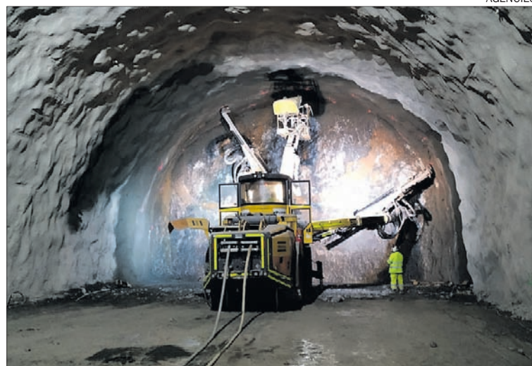
La part perforada del túnel de Trespunts.
