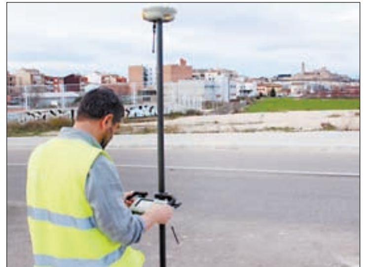
FOTO: T.A. / Trabajos topográficos previos a construir el nuevo vial
