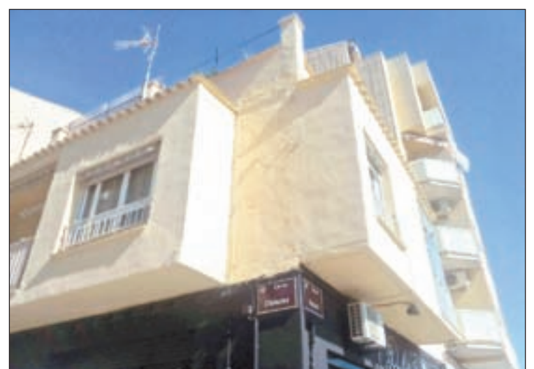
FOTO: D.A. / La pared ya está limpia de los cables enmarañados
