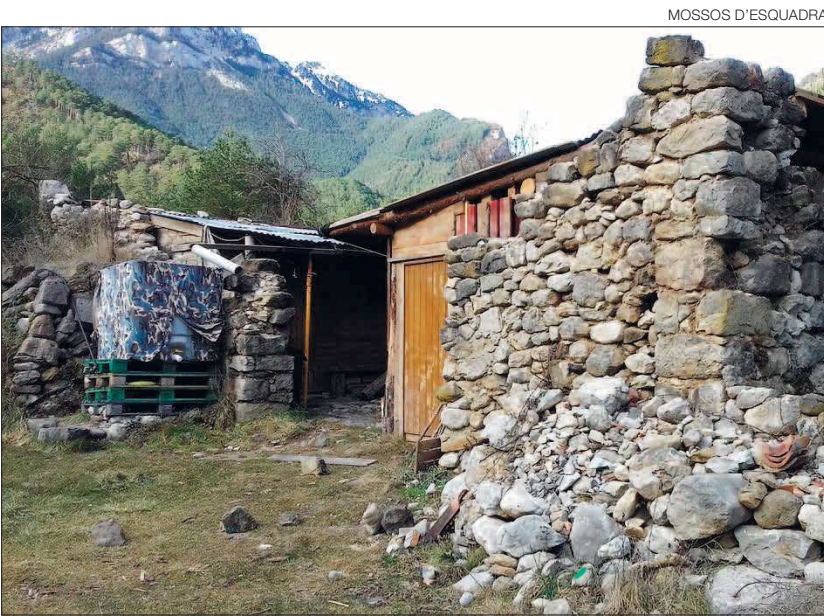
Imatge de l'edificació il·legal detectada a Saldes.
