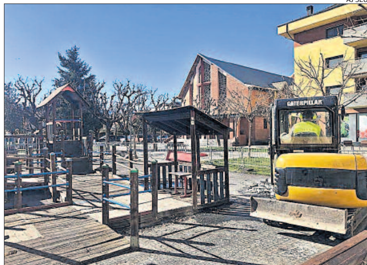
Els operaris treballant al parc infantil a Santa Magdalena
