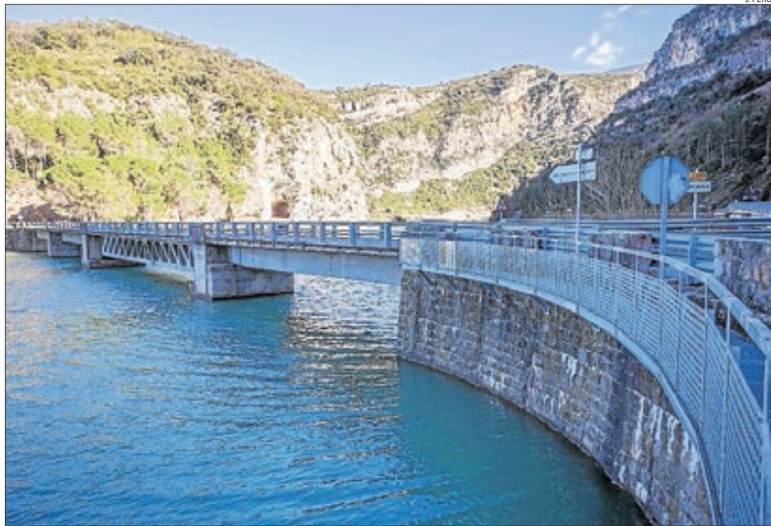
La passarel·la actual que acaba al pont on es construirà la nova, també adossada.
