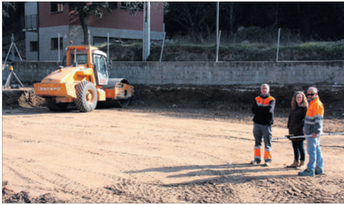
El nou edifici de l'Ajuntament de Bassella s'està construint al nucli d'Ogern.
