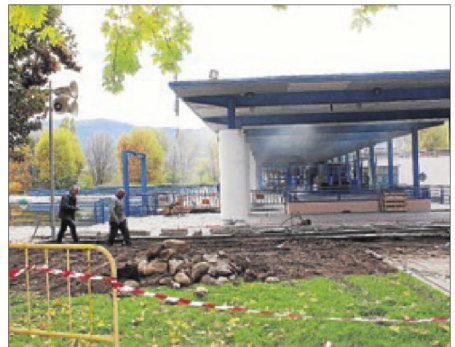
La zona urbana del recinte també es remodela.
