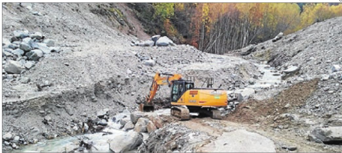
Els treballs se centren ara en la construcció d'una escullera al marge dret del Valarties.
