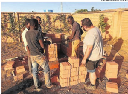
La construcció d'una fossa sèptica a Burkina Faso.
