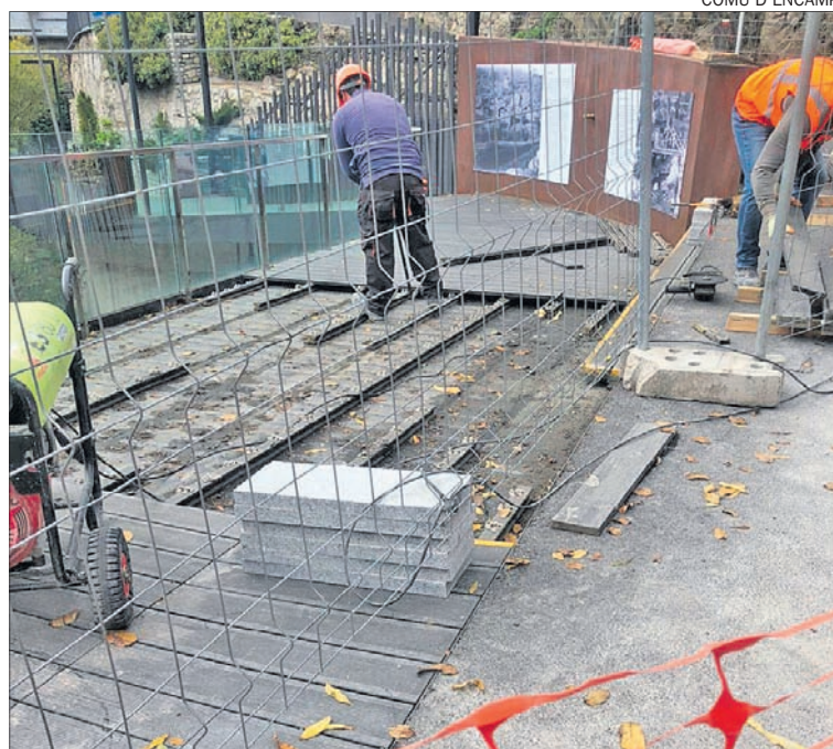
El canvi de paviment va començar dilluns i s'allargarà fins a finals d'aquest mes.
