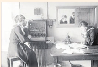
Dones treballant en una estació telefònica.
