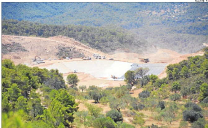
Imatge d'arxiu de les obres de l'abocador de Riba-roja l'estiu passat.
