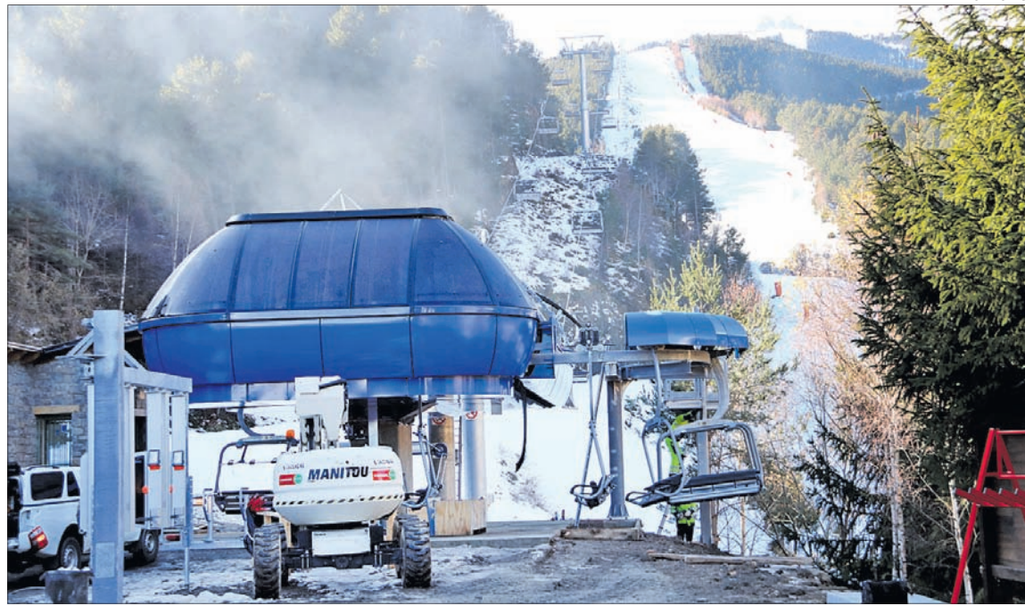
Les obres del nou telecarida de La Roca, a l'estació d'esquí d'Espot.
