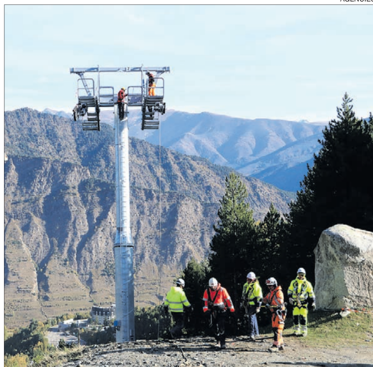
Un grup d'operaris treballen en la instal·lació d'una de les pilones del nou telecadira.
