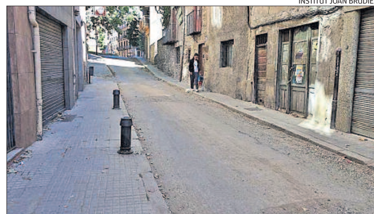
Estat actual de les obres del carrer dels Ferrers, a punt de pavimentar
