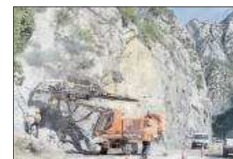
Treballs a la zona.
