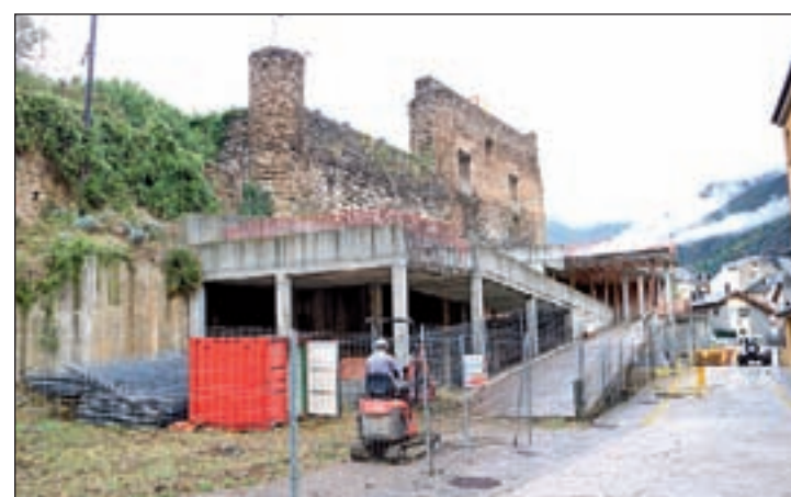
FOTO: M.Lluch (ACN) / Imatge de les obres de l'equipament
