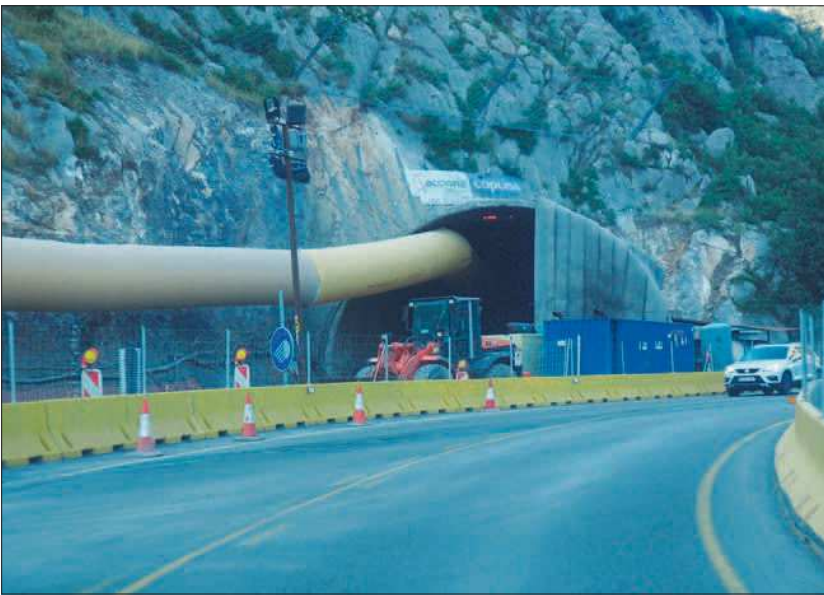
►► Les obres al túnel de Trespunts.
