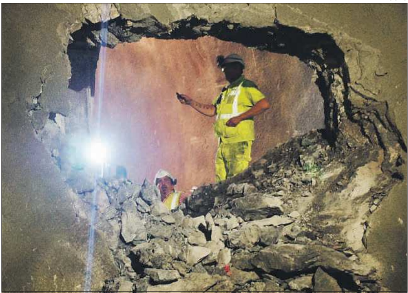
►► Perforació del túnel de Trespunts
