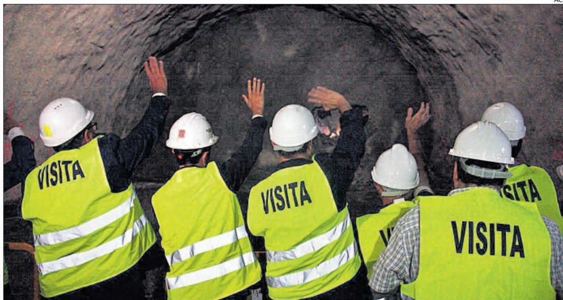
Les autoritats saluden els operaris de l'altre costat del forat, on estan acabant l'excavació
