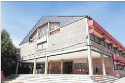
La instal·lació de les xarxes al perímetre començarà en breu.
