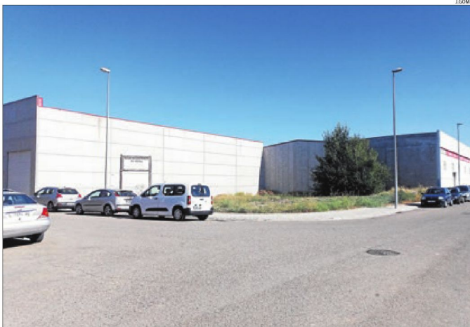
El solar que ha adquirit la comunitat per construir la mesquita.
