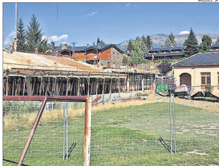
L'actual escola, a la dreta, i l'edifici que acollirà les noves aules
