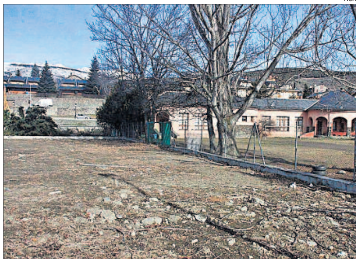
Espai on s'està construint el nou edifici, i l'antiga escola al fons
