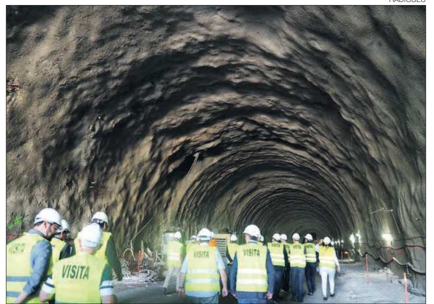
► Visita a les obres del túnel de Trespunts.
