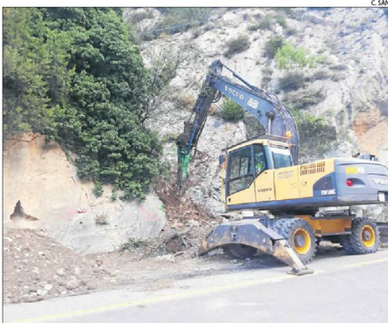
Inici de les obres d'embocadura a l'entrada al túnel.
